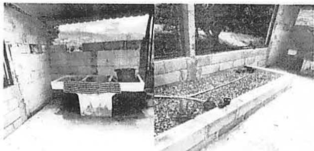
Foto 3: Demolición de inodoro ciego, reparación de muro perimetral existente inclinado
